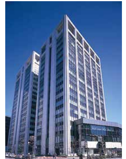
東京事務所・有楽町電気ビル南館 6階
